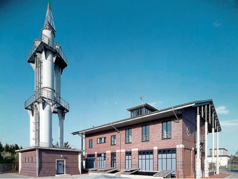
Das neue Pumpwerk Findorff mit „Wasserschloss“, kurz nach der Inbetriebnahme 1995.
