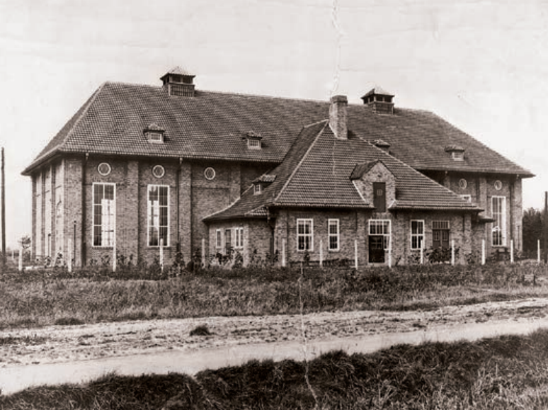
Das Pumpwerk in Findorff kurz vor seiner Inbetriebnahme 1915.
